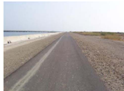
➤鋪設瀝青混凝土
