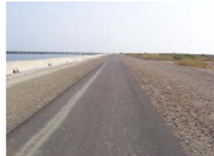
➤ 鋪設瀝青混凝土
